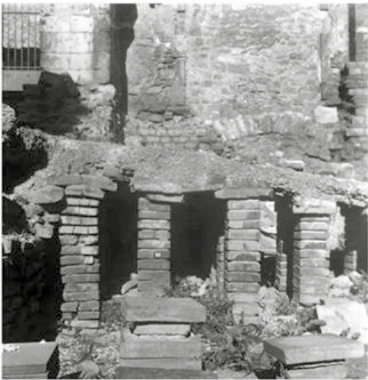
MSH Mondes PMD118/1/1, Archives nationales 20190308/13. Photographie des thermes d'Arles, le caldarium (sans date)
