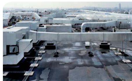
Toiture du bâtiment © Gilles Raynaldy/Oppic. architecte Fuksas
